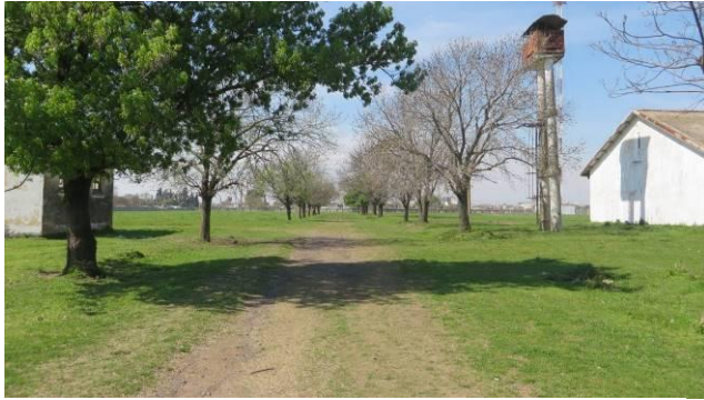
Sector de Servicios (depósitos)
