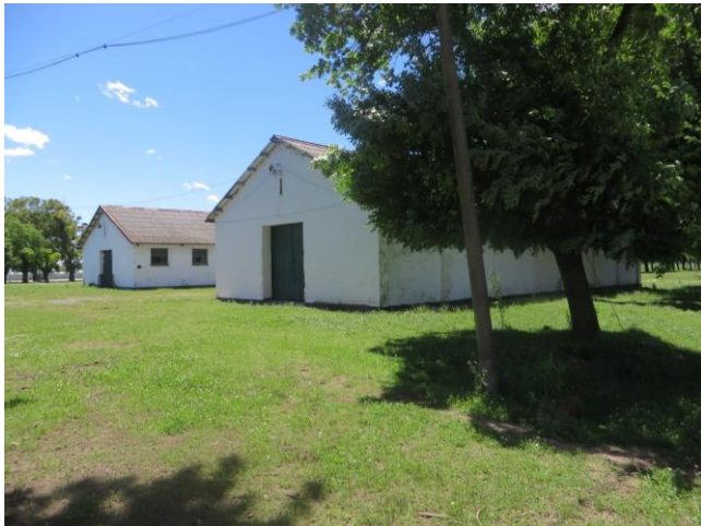
Sector de Servicios (depósitos)
